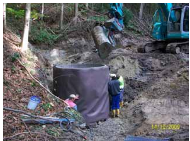
Neuer Brunnenschacht Hangquelle
