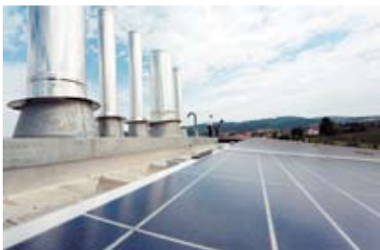
Unter diesem Dach wird gebacken, oben wird Strom erzeugt: Die Gläserne Backstube ist die neunte Gemeinschaftsanlage in Frickingen, 52 Bürger haben sich daran beteiligt.
